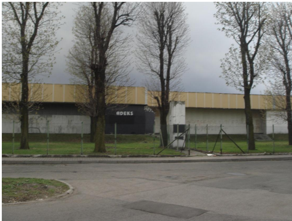
Rycina 18. Pomnik na osiedlu Ksawera. Obecne otoczenie
